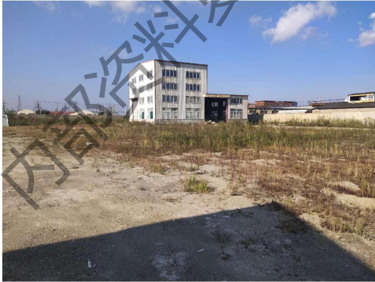
图 3-4 地块东北侧临时彩钢建筑物
