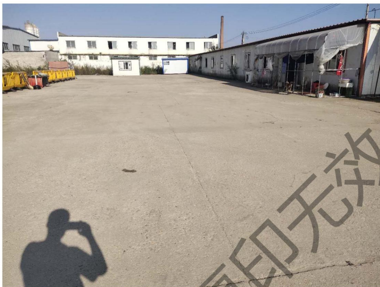
图 3-5 地块东北侧临时彩钢建筑物
